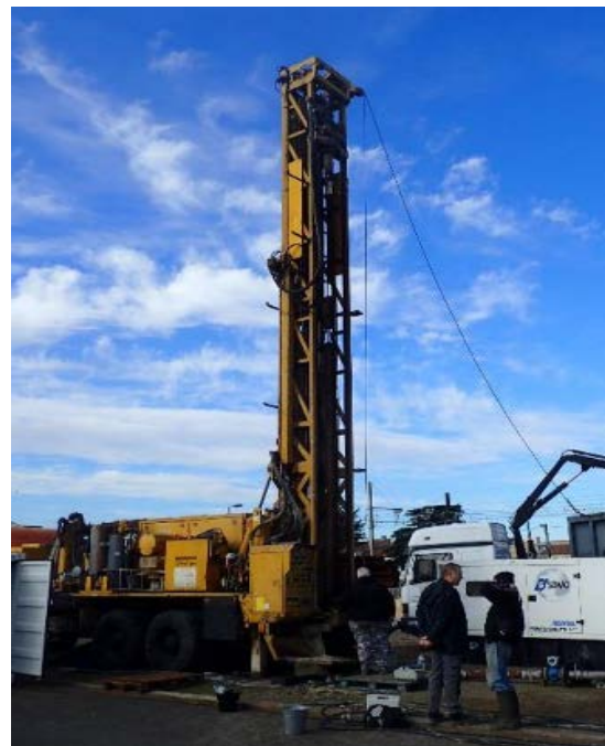
Réalisation du forage d'observation (Janvier 2018)
